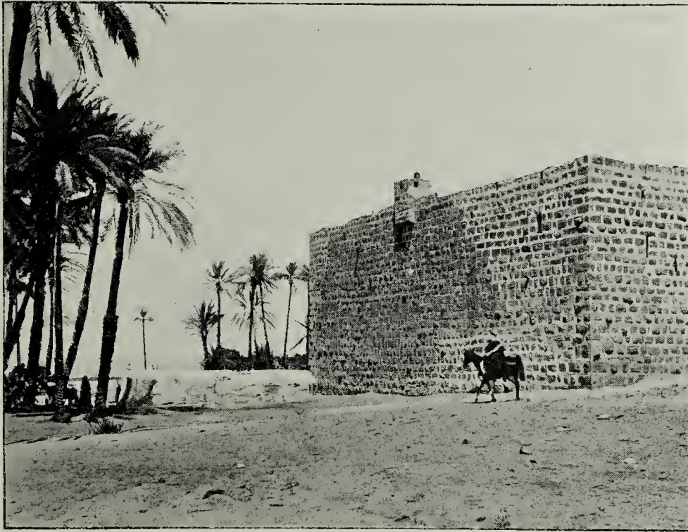
Fig. 41. — TEBOUK. Côté méridional et angle sud-est du château.
